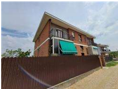
Prospetto lato strada
